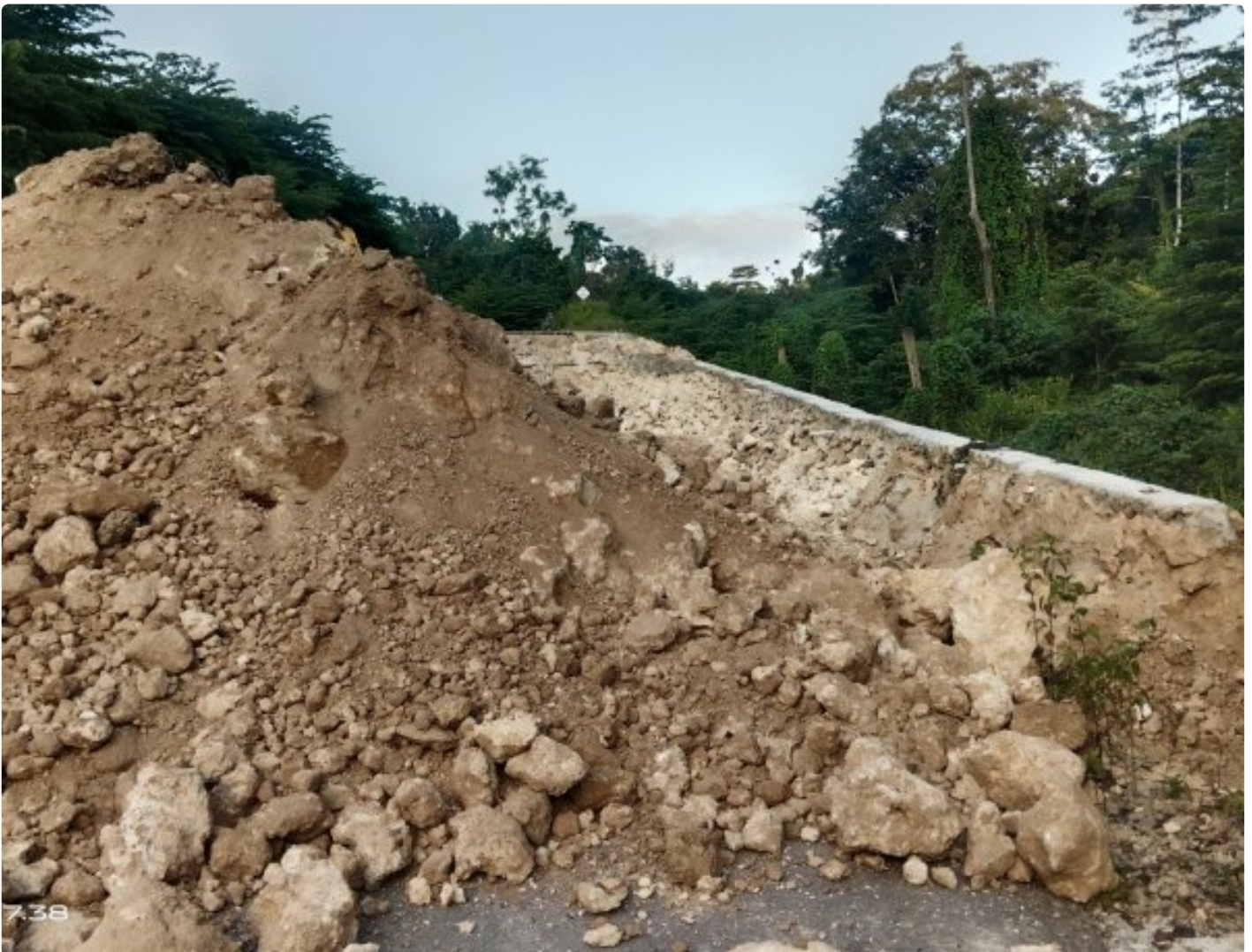
Pembongkaran Jalan Rusak Pada Pekerjaan Jalan Lingkar Anggaran 160 Milyar
